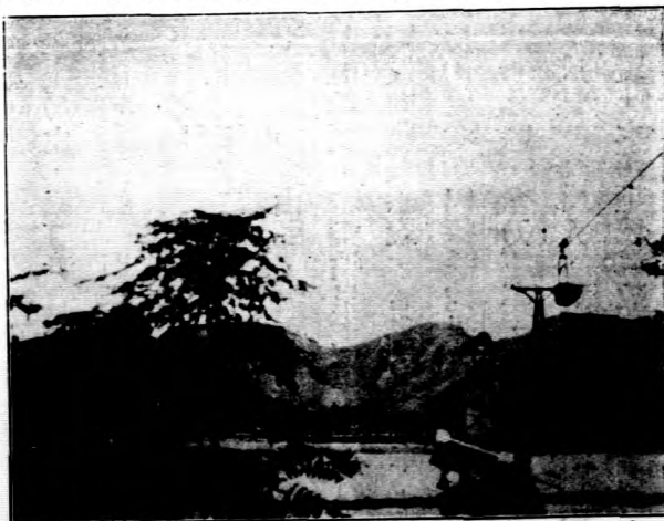
坨青高架綫鐵路
